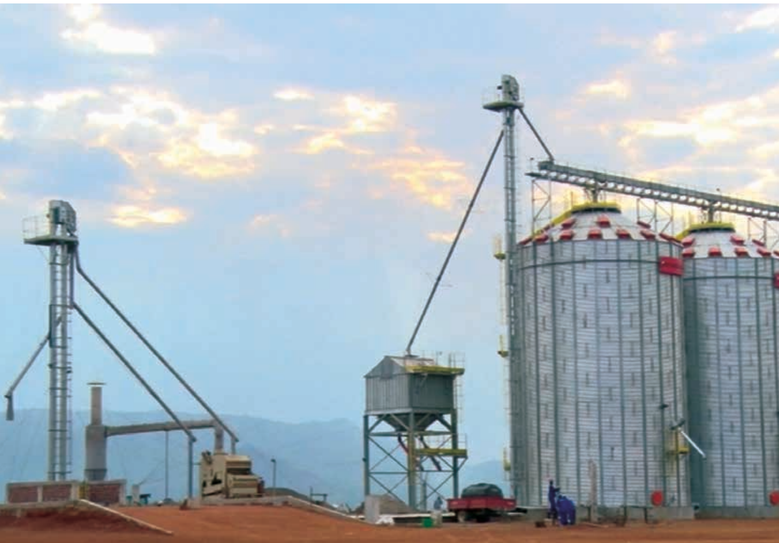
Silos da AgroMoz, usados para a armazenagem de cereais, Lioma, distrito de Gurúè
